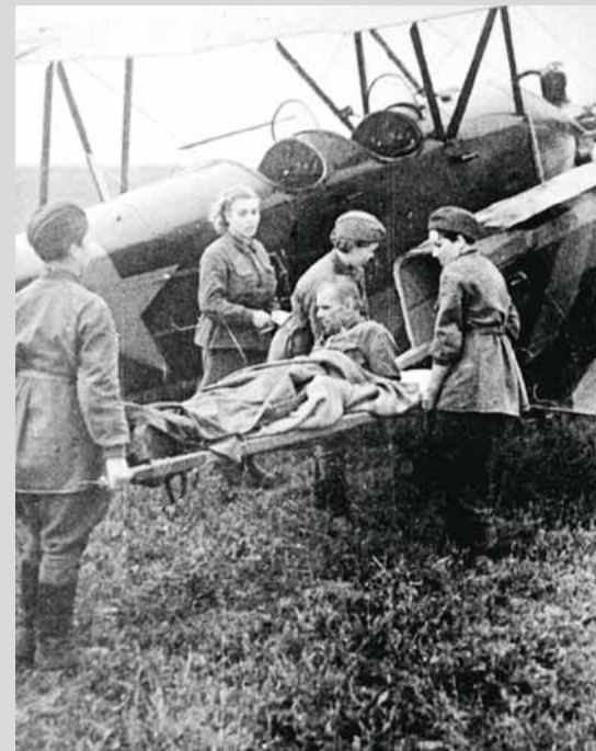
Эвакуация раненых бойцов на самолете У-2 в районе Сталинграда. Для перевозки раненых используются кассеты, устанавливаемые на нижние крылья. Кассеты состояли из площадки для носилок и легкой крышки над ними
