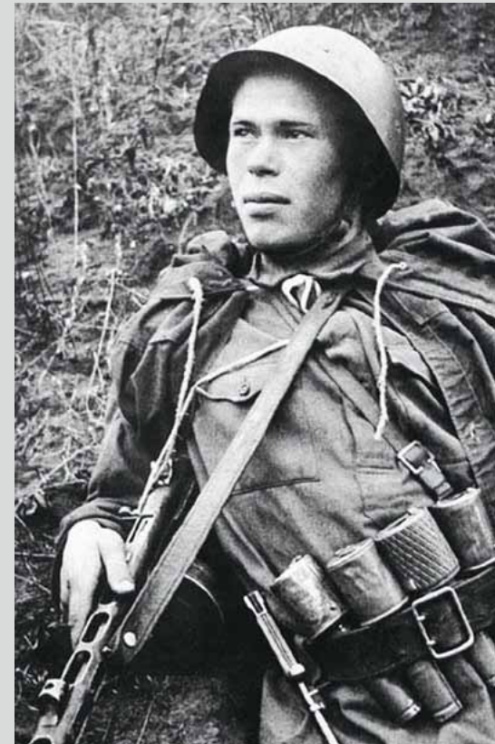
Разведчик Н. Романов, вооружённый пистолетом-пулемётом конструкции Шпагина ППШ-41 и четырьмя ручными гранатами конструкции Дьяконова РГД-33. На одной гранате надета «рубашка» с дополнительными осколками. В таком виде граната является оборонительной. Три других гранаты без «рубашек» являются наступательными
