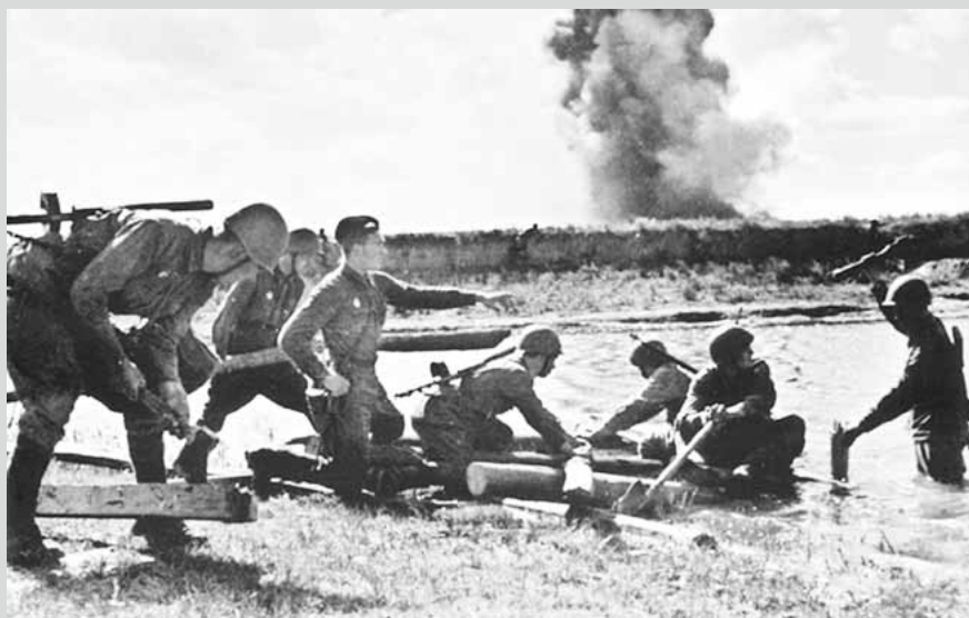
Советские сапёры-гвардейцы под командованием гвардии старшего лейтенанта П. Л. Белоцерковского за строительством переправы через водный рубеж в районе Сталинграда.
